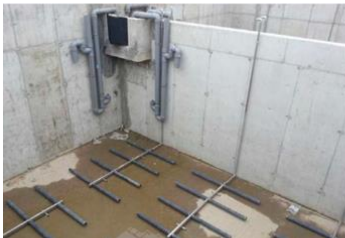
ნახ. 3.3.2.2. სადგურის შეგთავსის ზოგადი ხედი დიფუზიის ძელაკებითა და პნევმატური ამწის მილებით.
